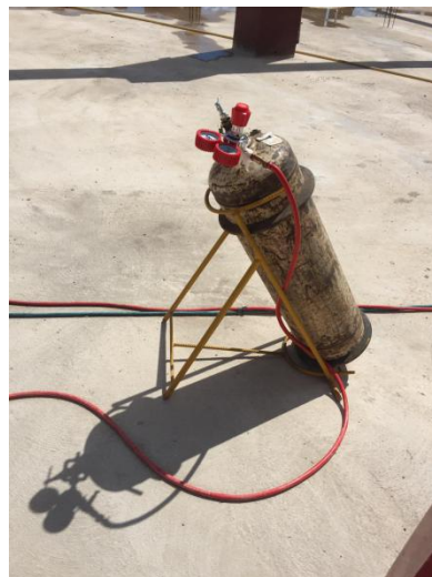
图 7.3-2 乙炔瓶防倾倒架
