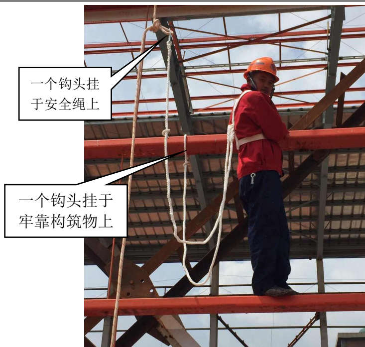
图 2.2.2-1 四点双背式安全带作业过程中系挂示意图
