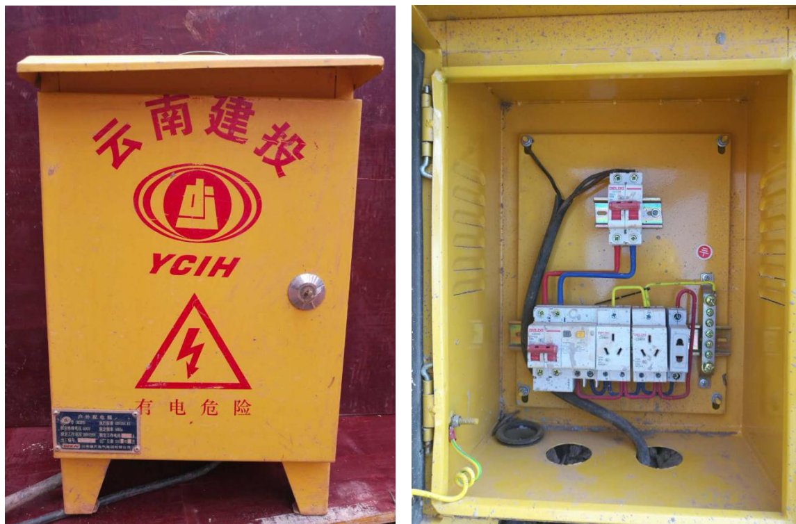
图 4.1.4 移动式手持电动工具开关箱
